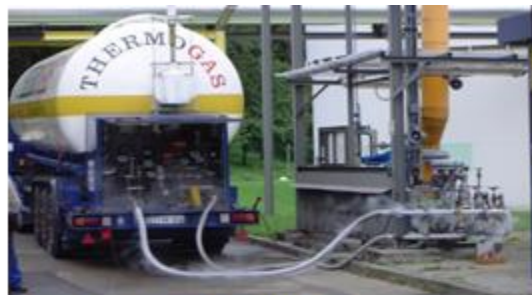
Fonte: foto do autor Thermogas, Stuttgart, Alemanha
