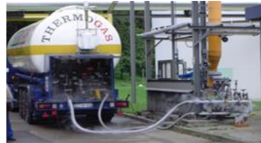
Fonte: foto do autor Thermogas, Stuttgart, Alemanha
